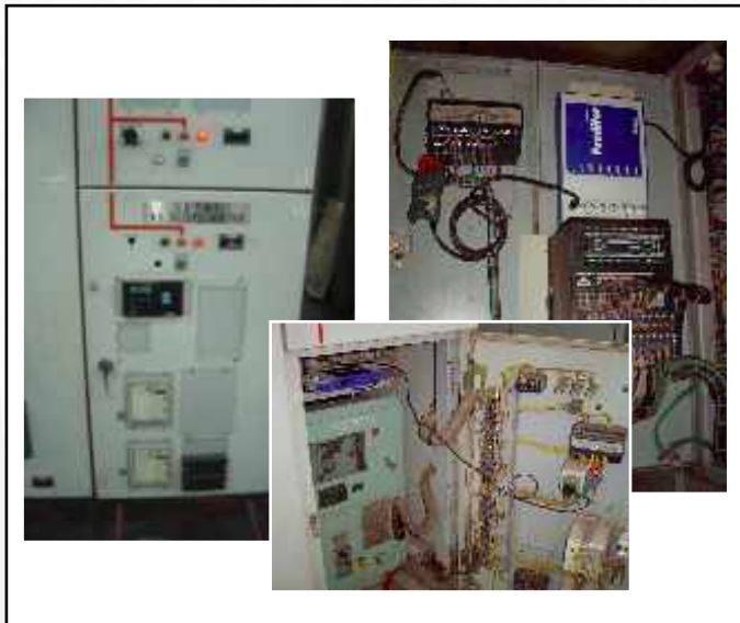
Preditor Online - hardware de aquisição no painel do motor acessado via rede. Até 6 motores monitorados por hardware.
