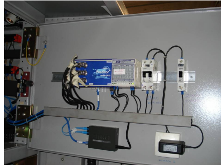
Figura 1: Sistema de monitoramento remoto no painel do motor.
