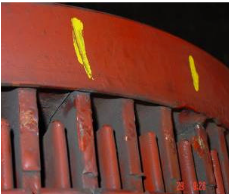
Figura 5 – Fotografia das barras quebradas.
