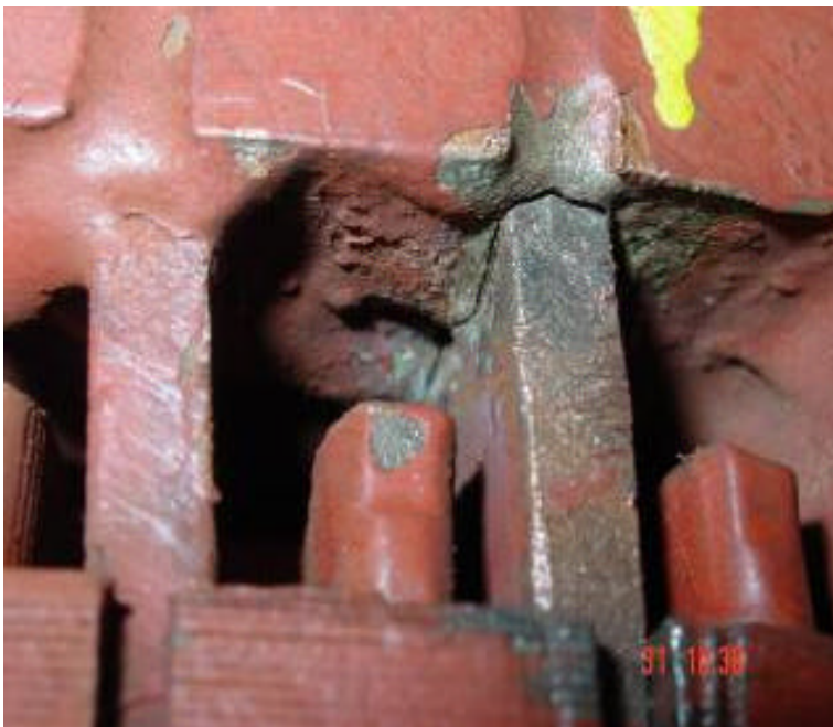
Figura 9 – Fotografia das barras quebradas.
