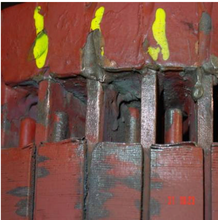
Figura 10 – Fotografia das barras quebradas.
