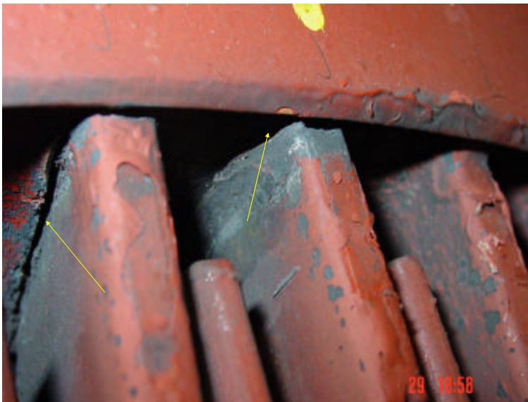
Figura 6 – Fotografia das barras quebradas.
